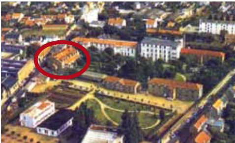
1972 : vue aérienne de l'ancien hôpital Laennec. En rouge, le pavillon D ou encore nommé "pavillon des femmes", seul bâtiment conservé aujourd'hui.
